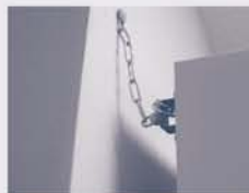
写真2.棚の転倒防止策
